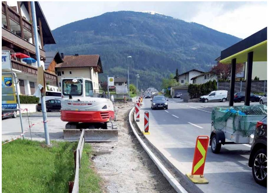
Eine weitere „Baustelle“ war der Gehweg im Bereich der Tankstelle. Aus Sicherheitsgründen wurde der Gehsteig angehoben und die Ein- bzw. Ausfahrten abgesenkt. Alle Arbeiten wurden in kompletter Eigenregie unseres Bauhofs durchgeführt.
